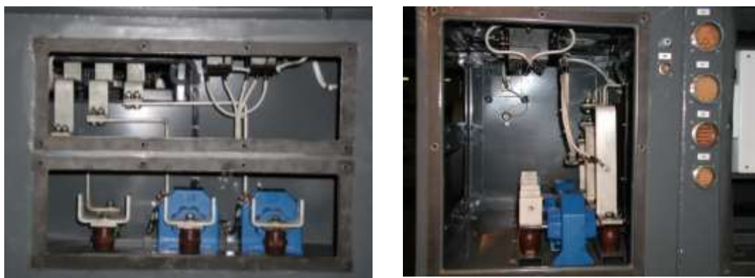
Рис.41 Датчики тока и напряжения
