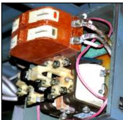
Рис.60 Крепление контактора в ящике
