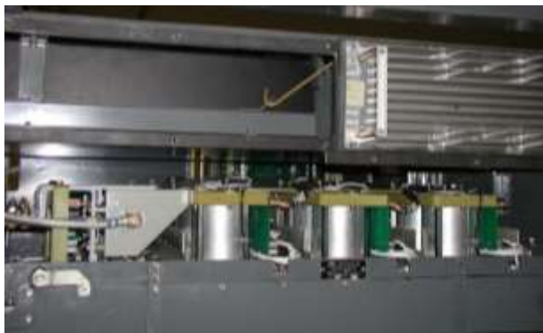
Фото.43 Конденсаторы сетевого фильтра
