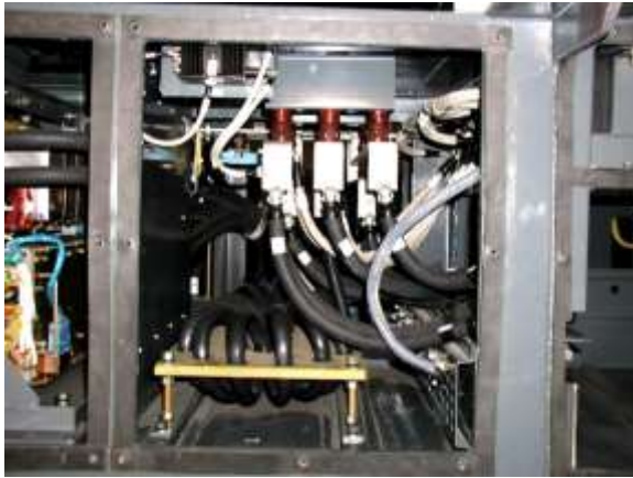
Рис. 48 Промежуточный дроссель фильтра
