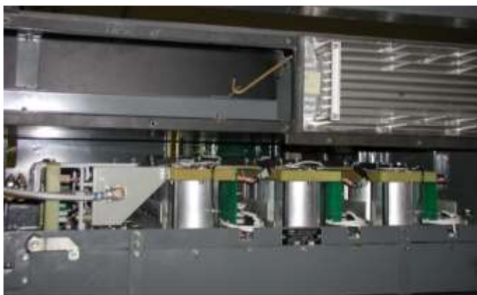
Рис.13 Конденсаторы сетевого фильтра
