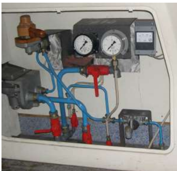
Рис. 91 Пост управления промежуточным вагоном 81-761
