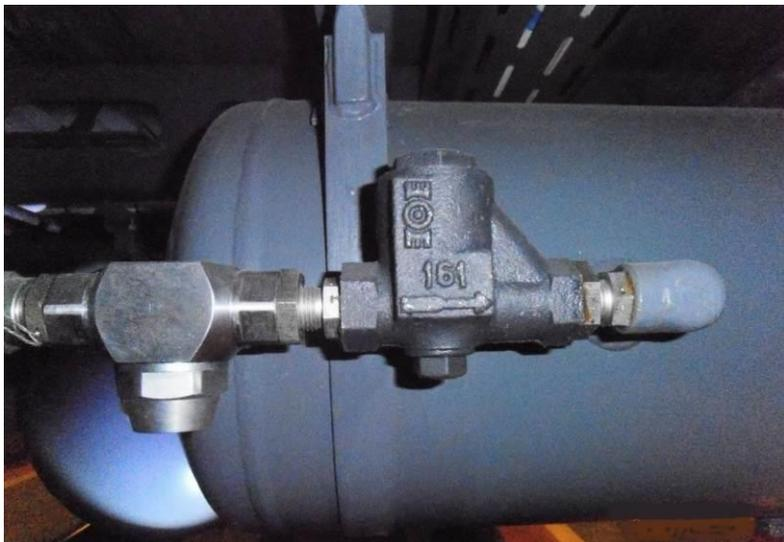
Для правильного монтажа клапанов в соответствующем трубопроводе напорной магистрали на корпусе каждого из них отлита стрелка, указывающая направление движения сжатого воздуха при открытом клапане.
