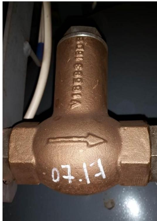
Рис. 11. Обратный клапан «Knorr-Bremse», установка на вагоне
